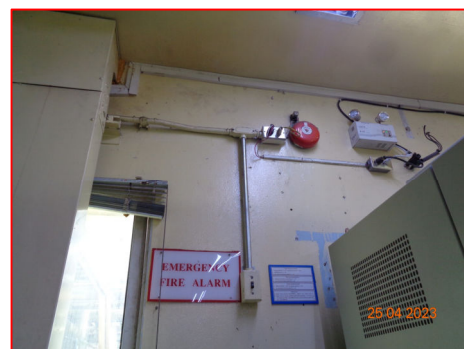
ภาพที่ 2.2-44 สัญญาณเสียงเตือนเหตุ เพลิงไหม้ (Fire Alarm)
