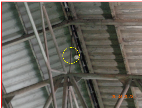
ภาพที่ 2.2-36 ระบบตรวจจับควัน (Smoke Detector) บริเวณพื้นที่อาคาร Ware House
